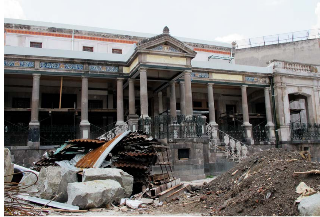
Imagen 26. Casa del ilustre arquitecto Antonio Rivas Mercado, autor de la Columna de la Independencia entre otras obras relevantes. Obra de restauración en proceso.
