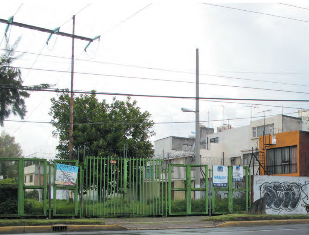
Imagen 20. El parque lineal es en realidad un paso de líneas de alta tensión en dirección Norte-Sur.
