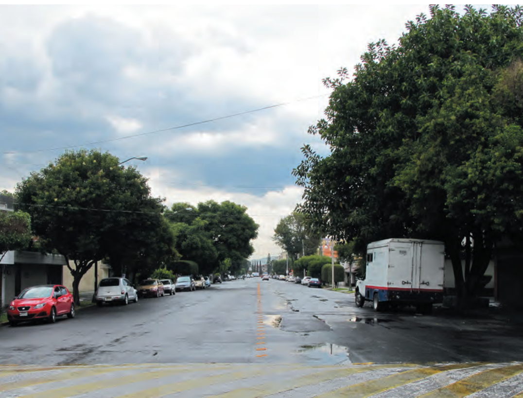
Imagen 18. Vista de la Calle Playa de Miramar que es la que remata con el Parque de Las Rosas. La calidad espacial de la calle es de una gran generosidad y escala para ésta colonia habitacional.
