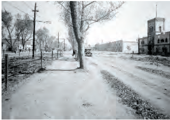
Imagen 6. Pese a su importancia histórica, ambiental, económica, de identidad, en 1940 se declara insostenible su estado de contaminación por drenajes y se decide entubarlo, cubrirlo y pavimentarlo, convirtiéndolo en uno de los principales drenajes de la ciudad y una amplia y congestionada avenida con tranvías y autos.
