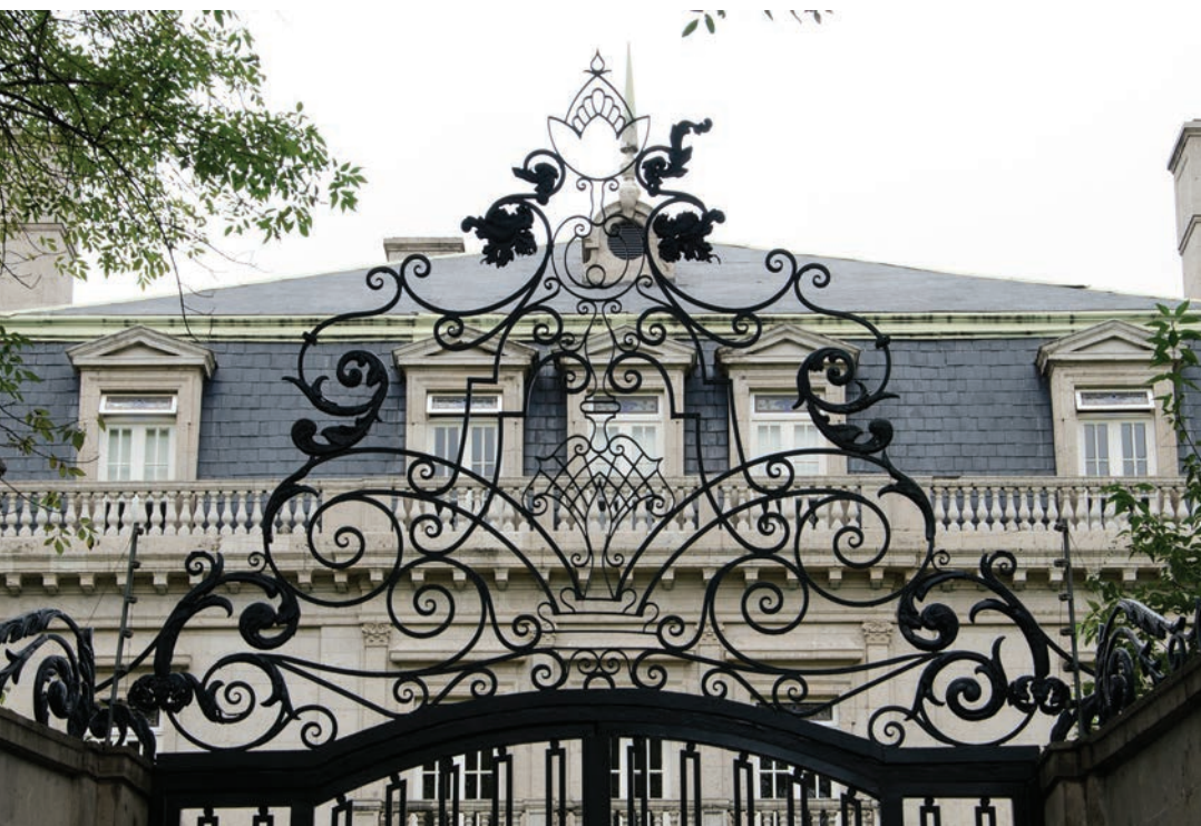
Imagen 29. Detalle del acceso y la portada principal de la casa sobre la Avenida Toluca 615.
