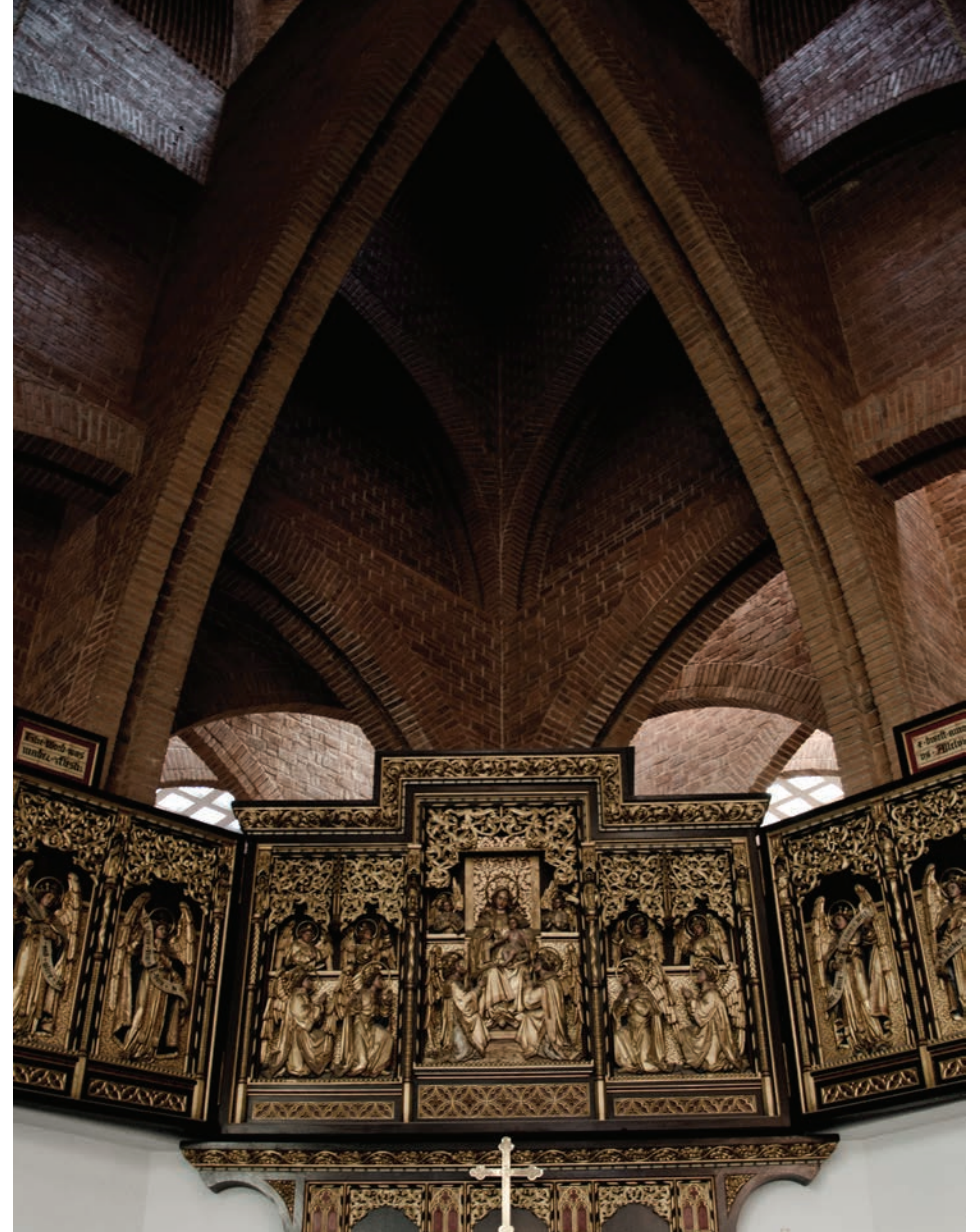
Imagen 38 y 39. Detalle del altar donde se aprecia la sorprendente ejecución de arcos entrelazados para conformar una muy particular cúpula realizada en tabique aparente.
