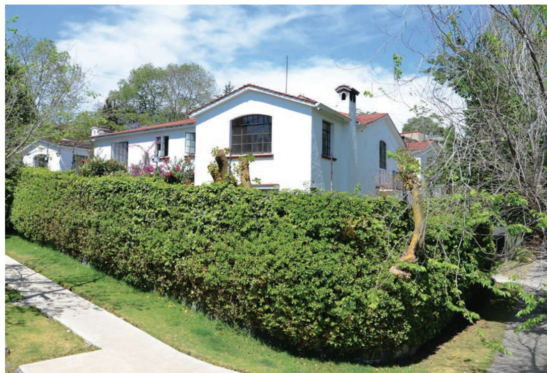
Imagen 16. Casa de estilo campestre neo californianas o neo colonial que conservan la esencia de la imagen original de la colonia, con setos perimetrales bajos en lugar de bardas, dando la impresión de continuidad con las calles arboladas.
