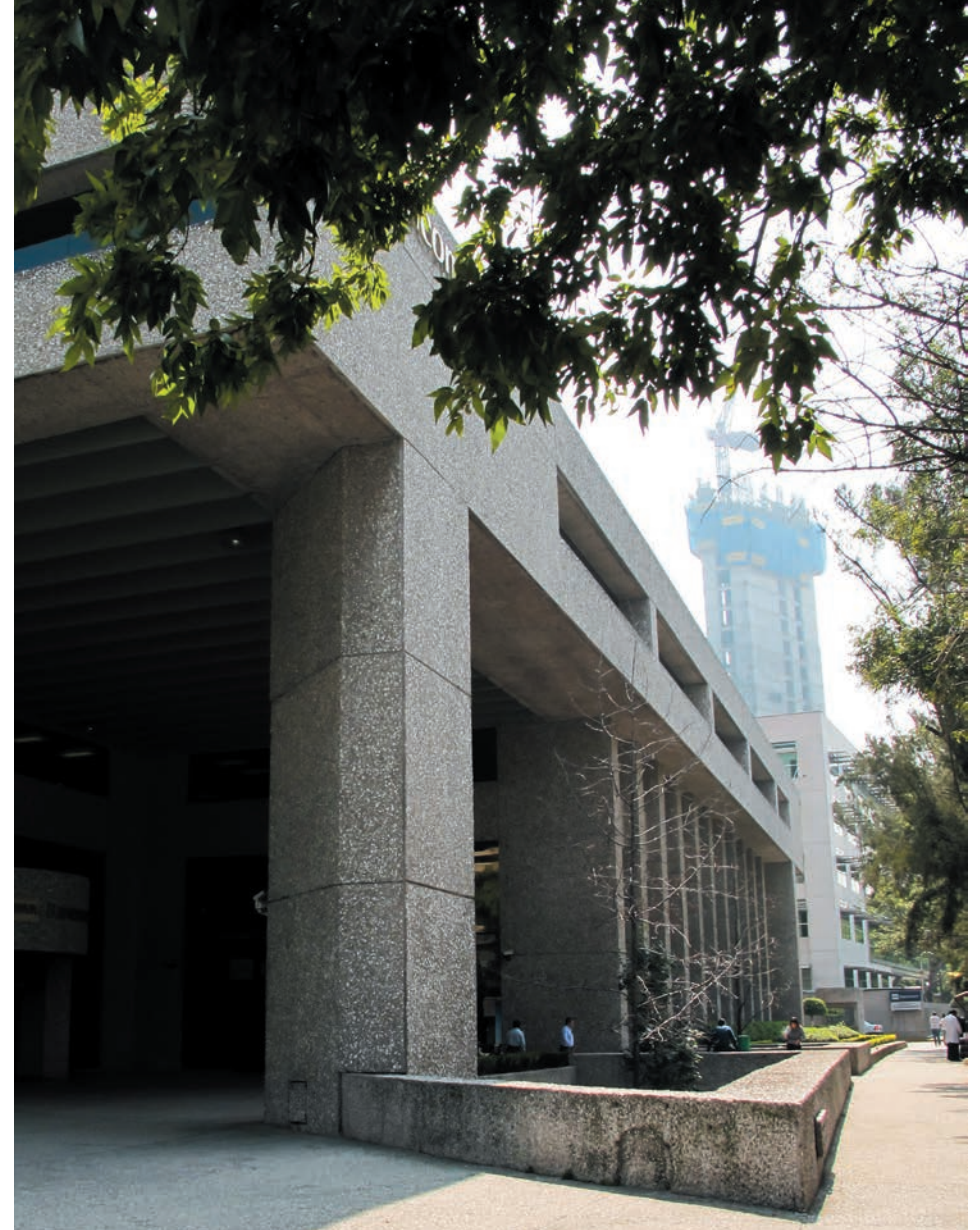
Imagen 37 y 37a. Edificios bancarios sobre Paseo de la Reforma, en la esquina con Montes Urales. Ambos realizados están realizados en un mismo material de mármol y concreto martelinado y dan presencia con sus generosos vestíbulos como plaza acceso a triple altura.
