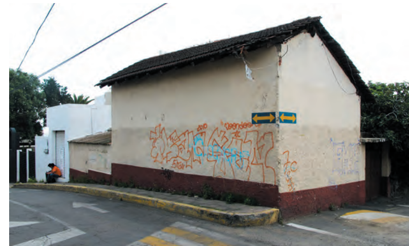
Imágenes 21,22 y 23. Vista de la esquina de una de las casas tipo de principios del siglo XX, edificada en adobe con aplanado rústico de protección y sencillos techos a dos aguas.
