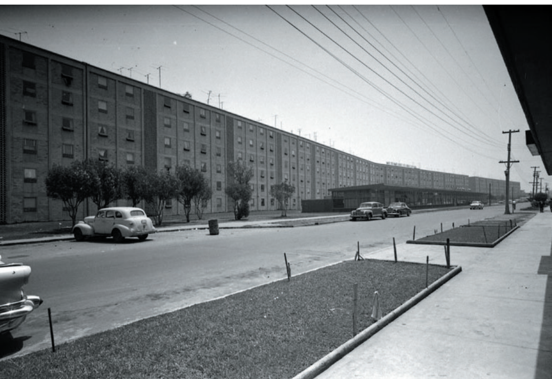
Imagen 6. Vista del edificio de vivienda de la Unidad Habitacional IMSS Narvarte de más de 600 metros de longitud.
