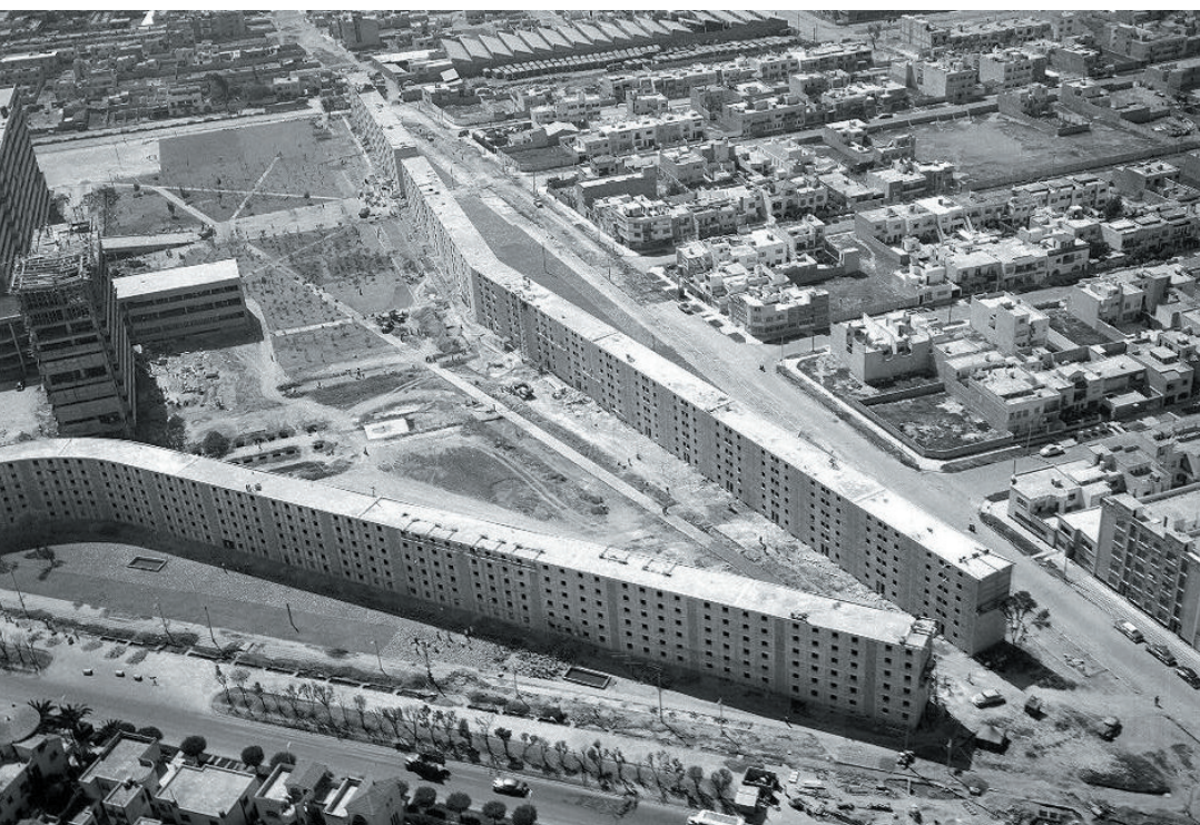
Imagen 13. Vista aérea de 1954 donde se ve el conjunto de la SCOP –hoy Secretaria de Comunicaciones y Transportes-, y de los extensos edificios de la Unidad Habitacional IMSS Narvarte remarcando todo el perímetro Sur y Poniente del predio.
