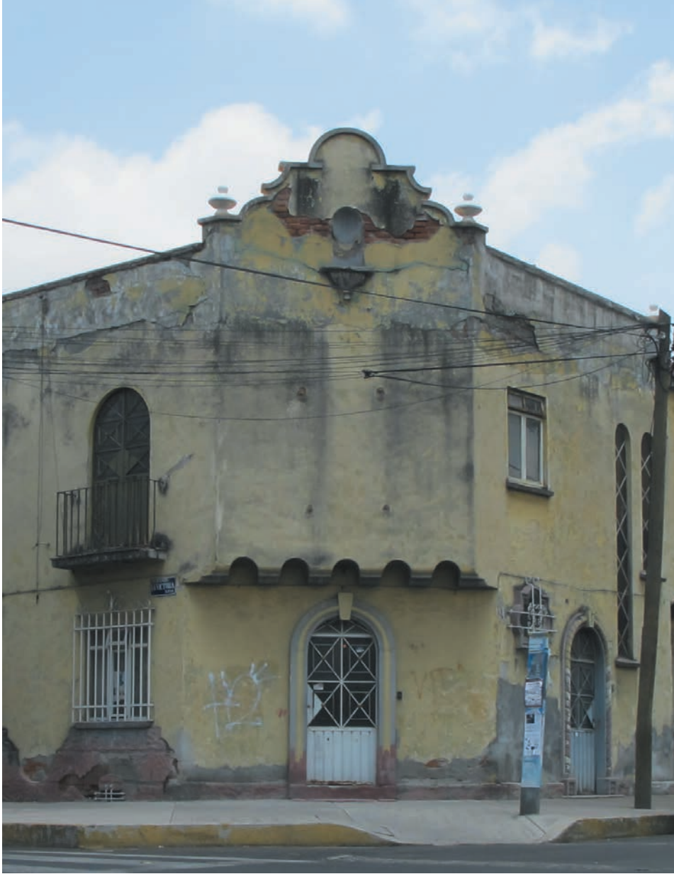
Imágenes 10 y 11. Construcciones en las esquinas de la Industrial, con fachada en pancoupé o recorte a 45 grados.
