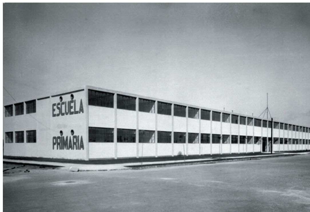
Imagen 26. Primer tramo construido por Juan O'Gorman para las escuelas primarias Emiliano Zapata y Jesús Romero Flores en la Colonia Industrial.
