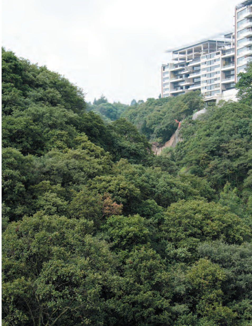
Imagen 19. Las barrancas no han sido límites para la voracidad inmobiliaria. Todo terreno es construible, terrenos flojos sobre minas de arena, zonas boscosas, lechos de ríos o vasos reguladores. En la imagen se aprecia una de las barrancas recortadas y sostenidas con concreto lanzado entre las que se intercalan grandes tajos excavados para dar lugar a nuevos edificios en Paseo de Tabachines.
